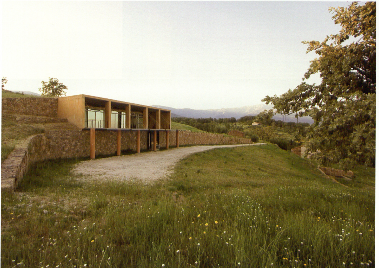
La vivienda se sitúa en una finca de fuerte topografía. The house is located on a farm with extreme topography.
